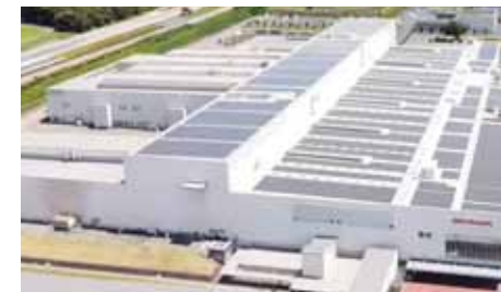
▲工場の屋根に設置された太陽光発電システム
