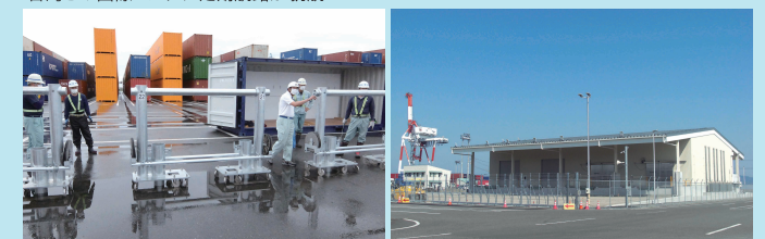
高潮対策のコンテナ流出防止柵
