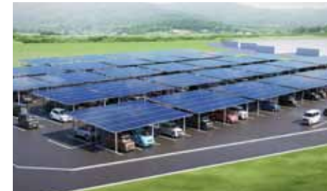
▲設置を進めているカーポート型太陽光発電設備
