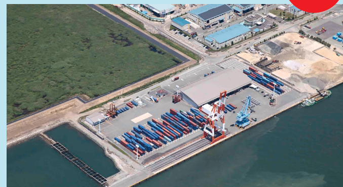
熊本港 (コンテナターミナル)
