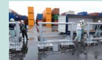
高潮対策のコンテナ流出防止柵
