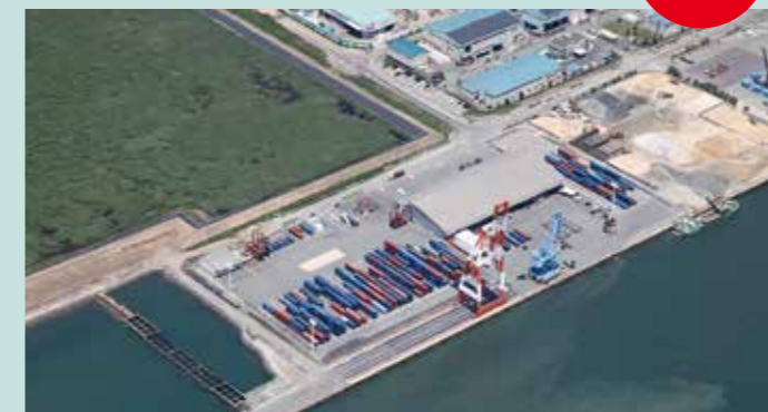
熊本港(コンテナターミナル)
