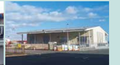
CFS倉庫(小口貨物積替上屋)
