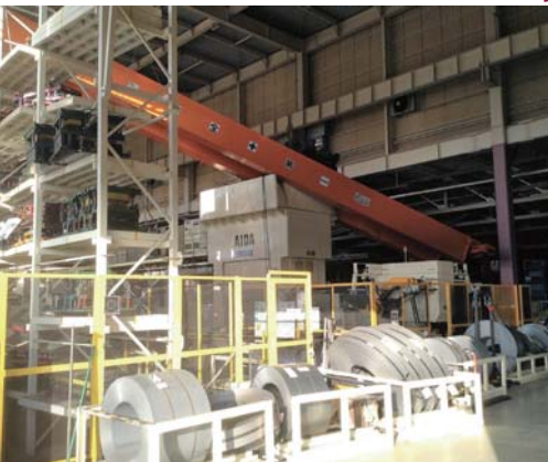
本震で天井吊りの大型クレーンが落下にあった500tプレス機に落下
