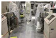
復旧後の梱包機内
