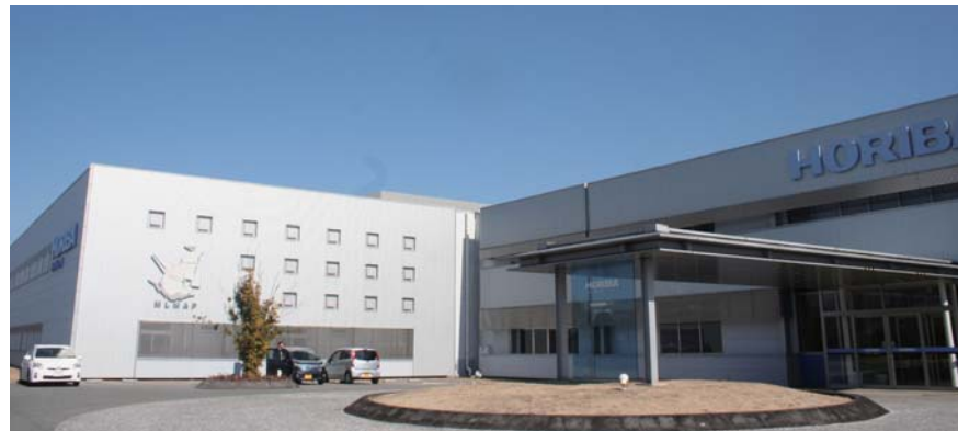
堀場エステック阿蘇工場
