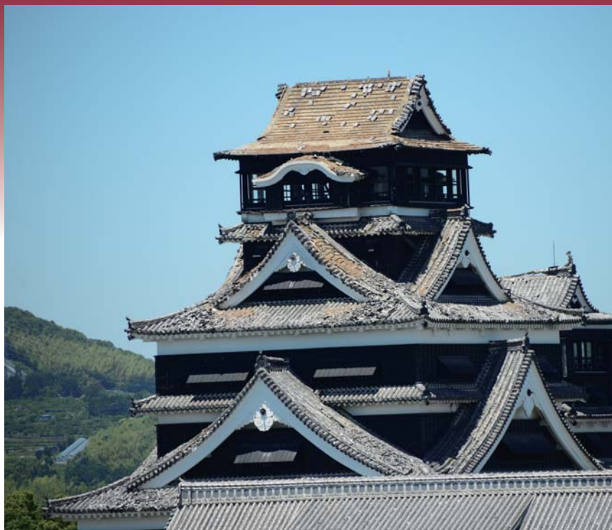
(平成28年熊本地震で被災した熊本城天守閣)
