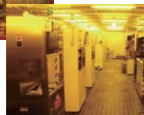
復旧後のクリーンルーム
