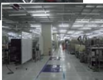
復旧したクリーンルーム
