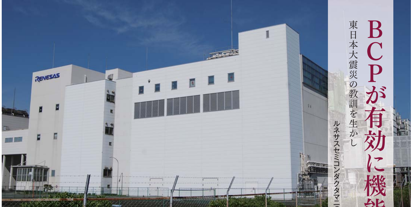
ルネサスセミコンダクタマニファクチャリング(株)川尻工場。東日本大震災で被災した那珂工場の教訓を生かし耐震性を強化していたため、建屋の被害は少なかった
