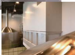
復旧後の仕込み室
