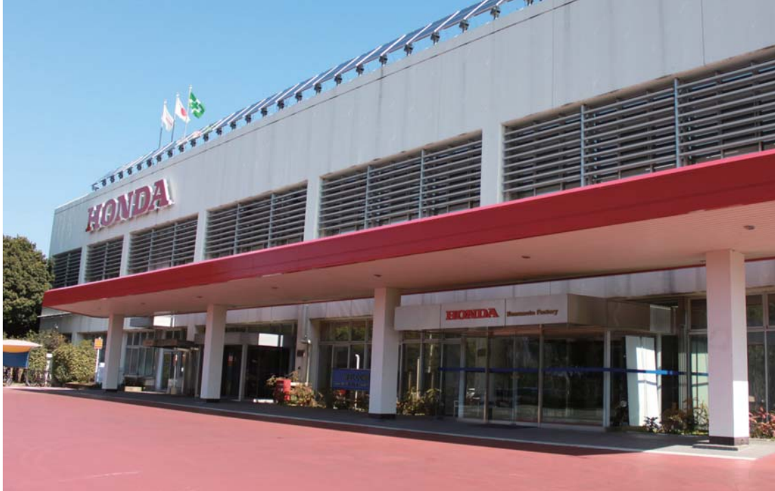
本田技研工業㈱熊本製作所の正面玄関。同製作所の敷地面積は約165万㎡
