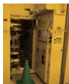
復旧後の拡散炉
