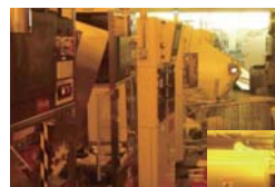
被災直後のクリーンルーム
