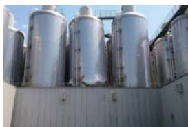
震災で傾いたビールタンク
