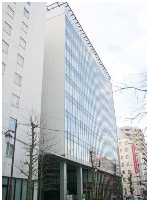
トランスコスモス(株)BPOセンター熊本が入居する中央区辛島町のNBFビル。
