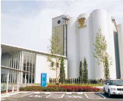
平成15年7月に完成したサントリー九州熊本工場
