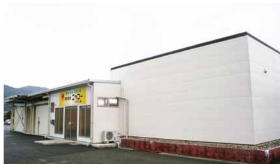
八代市二見本町に完成した工場
