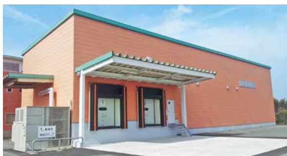
フードパル熊本(熊本市北区)の熊本工場
