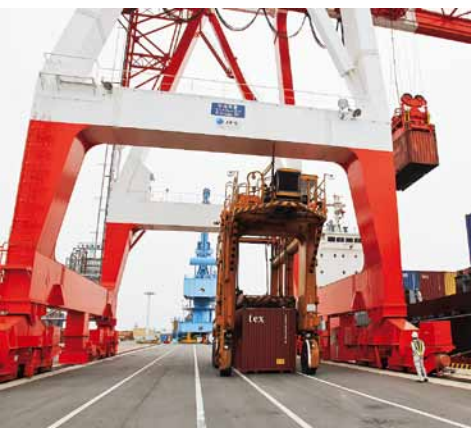
▲12年10月に設置した熊本港のガントリークレーン
