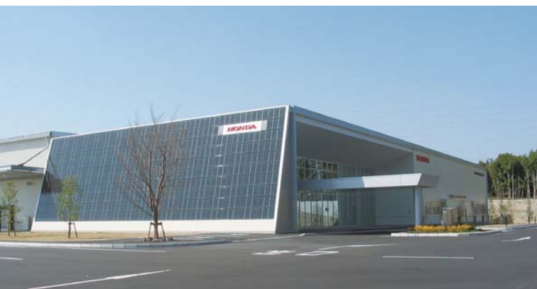
大津町平川の本社・工場。壁面には21kwの太陽電池モジュールを設置し、事務棟の照明に必要な電力を自社発電している
