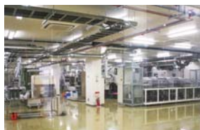
完成間際のクリーンルーム
