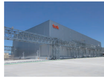
東京応化工業(株) 阿蘇工場くまもとサイト (画像提供:東京応化工業(株))
