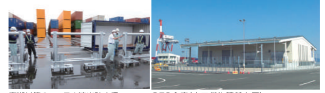
高潮対策のコンテナ流出防止柵 CFS倉庫 (小口貨物積替上屋)
