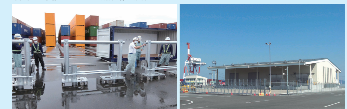
高潮対策のコンテナ流出防止柵
