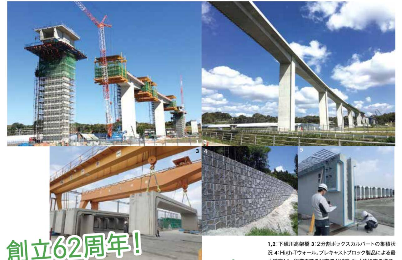
1,2:下硯川高架橋 3:2分割ボックスカルバートの集積状況 4:High-Tウォール。プレキャストブロック製品による最大壁高14m程度までの鉛直壁が特徴 5:寸法検査の様子
