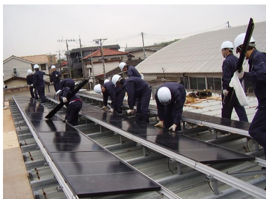
（太陽光パネル施工訓練風景）
