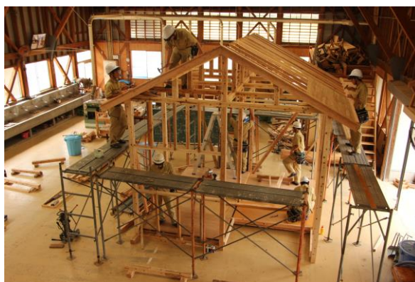
（住宅施工建て方訓練風景）
