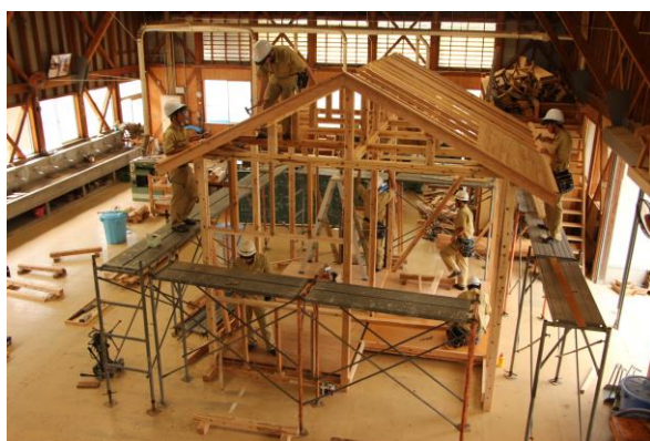
（校内訓練での棟上げ作業風景）
